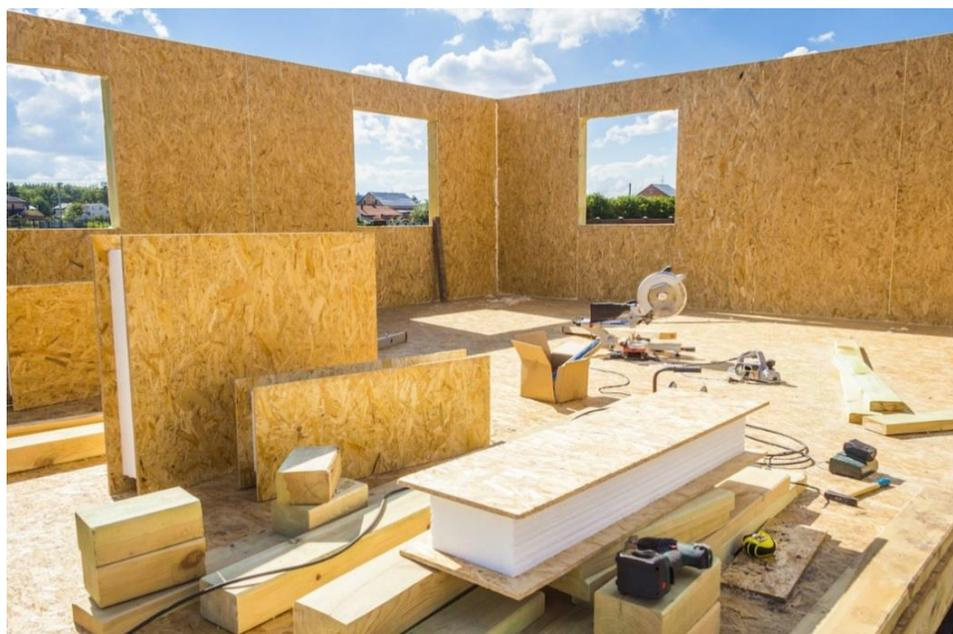
**Рис. 3. Установка и стыковка СИП-панелей**
